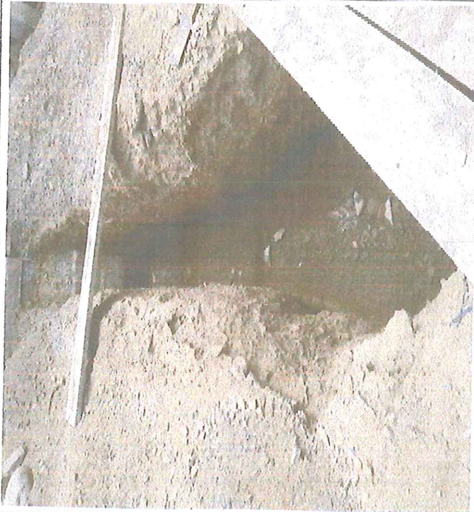
EXCAVACION EN ZONA PATIO DE REDES
